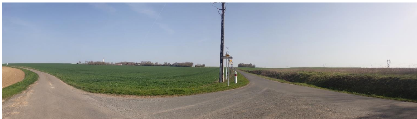
Photo 46 : Marandé et son château d'eau en position de point haut sur le plateau Source : ADEV Environnement
